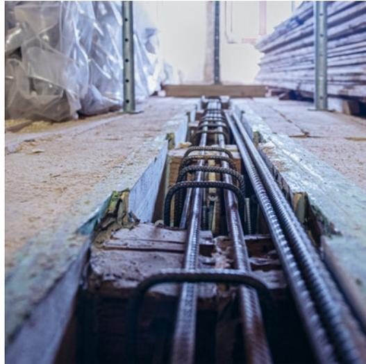
Nummerierte historische Tonbodenplatten für Wiederverlegung und Verstärkung der Bodenkonstruktion
