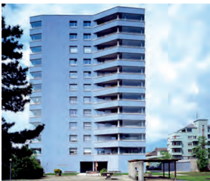
Sanierung Hochhaus Zurmattenstrasse, Solothurn Architekten: Egli Rohr Partner AG, Architekten BSA/SIA, Baden
