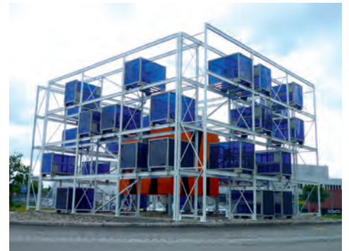
Kreiselgestaltung, Neuendorf Architekten: Schneider Landschaftsarchitekten bsla AG, Olten
