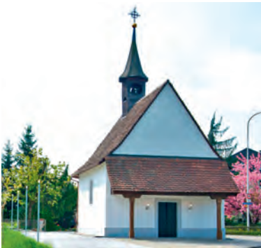
Gesamtrestaurierung Allerheiligenkapelle, Derendingen Architekten: Peter Widmer, dipl. Arch. ETH/SIA EURING, wwB Architekten AG, Solothurn
