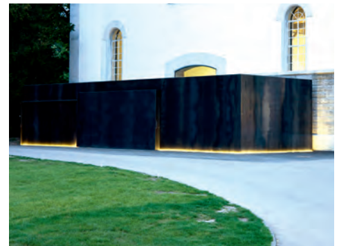
Neubau öffentliche Toilettenanlage, Solothurn Architekten: Guido Kummer + Partner, Architektur + Planung HTL SWB, Solothurn
