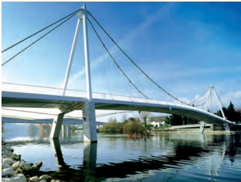
Fussgänger-Aarebrücke, Solothurn Ingenieure: Fürst Laffranchi Bauingenieure GmbH Gestalterische Beratung: Nissen & Wentzloff Architekten, Basel
