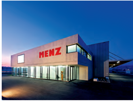
Halle mit Bürobau, Menz AG, Luterbach Architekten: E+P Architekten AG FH SIA, Solothurn
