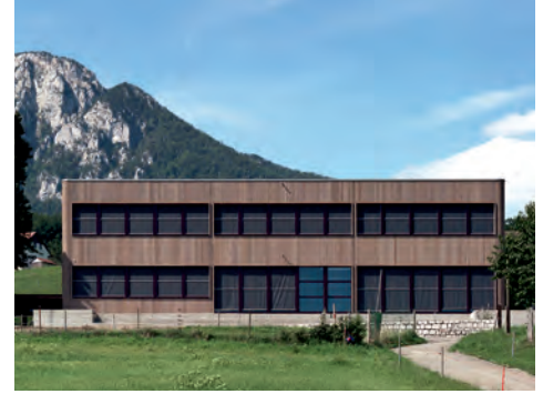
Bildungszentrum Wallierhof, Riedholz Architekten: ern+heinzl Architekten, Solothurn
