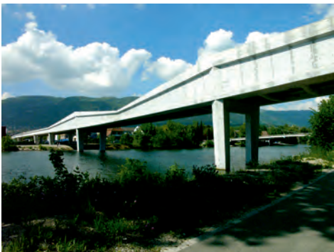
Aarebrücke Entlastung West, Solothurn Ingenieure: Fürst Laffranchi Bauingenieure GmbH Gestalterische Beratung: Nissen & Wentzlaff Architekten, Basel
