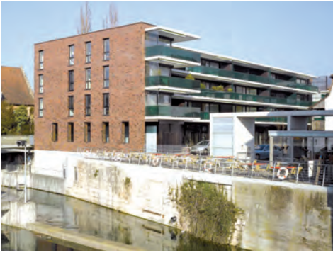
Bebauung Nepomuk, Dornach Architekten: Zwimpfer Partner Architekten, Basel, Zürich
