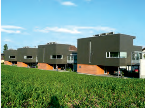
Minergiesiedlung Kirchacker, Oberdorf Architekten: Aarplan Architekten AG, Solothurn
