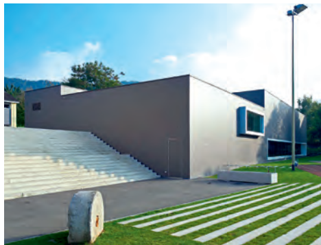
Neubau Turnhalle Kirsgarten, Büsserach Architekten: Dorji Sigrist Architekten, Luzern
