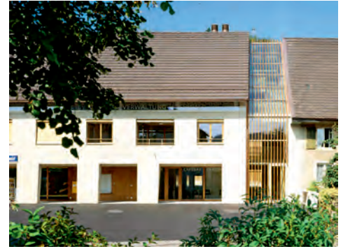
Gemeindezentrum Hochwald Architekten: Architektengemeinschaft Nussbaumer Trüssel Architekten und Schwob & Sutter Architekten, Bubendorf
