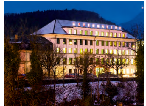
Umbau Alternative Bank ABS, Olten Architekten: Metron Architektur AG, Brugg
