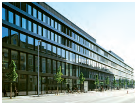
Wohn- und Geschäftshaus Perron 1, Solothurn Architekten: Morger + Dettli Architekten AG BSA/SIA, Basel
