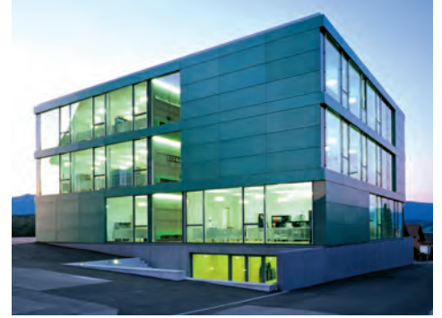
Neubau Schulhaus und Gemeindeverwaltung, Umbau Kindergarten, Gestaltung Dorfplatz, Starrkirch-Wil Architekten: wbachitekten ETH SIA, Bern
