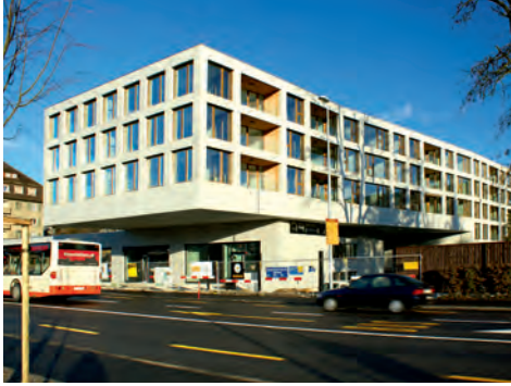
Neubau Wohn- und Geschäftshaus Schänzlipark, Solothurn Architekten: Flury und Rudolf Architekten AG, Solothurn
