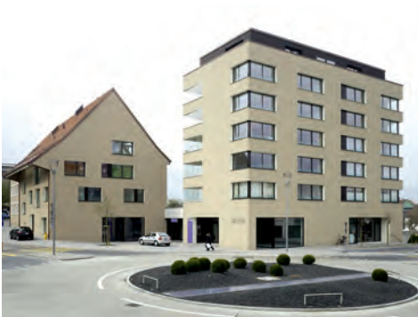
Überbauung Central Breitenbach, Breitenbach Architekten: Zwimpfer Partner Architekten, Basel, Zürich
