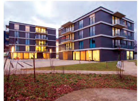
Wohnheim mit Tagesstätte, Rodania, Grenchen Architekten: Architektengemeinschaft Biel_97 k2p Architekten GmbH, Biel
