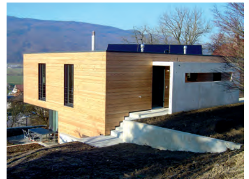
EFH Aeschlimann, Kestenholz Architekten: TKS Architekten AG, Solothurn
