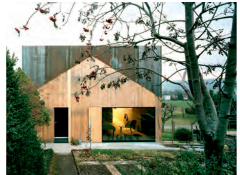
Wohn-/Atelierhaus, Büsserach Architekten: Degelo Architekten, Basel
